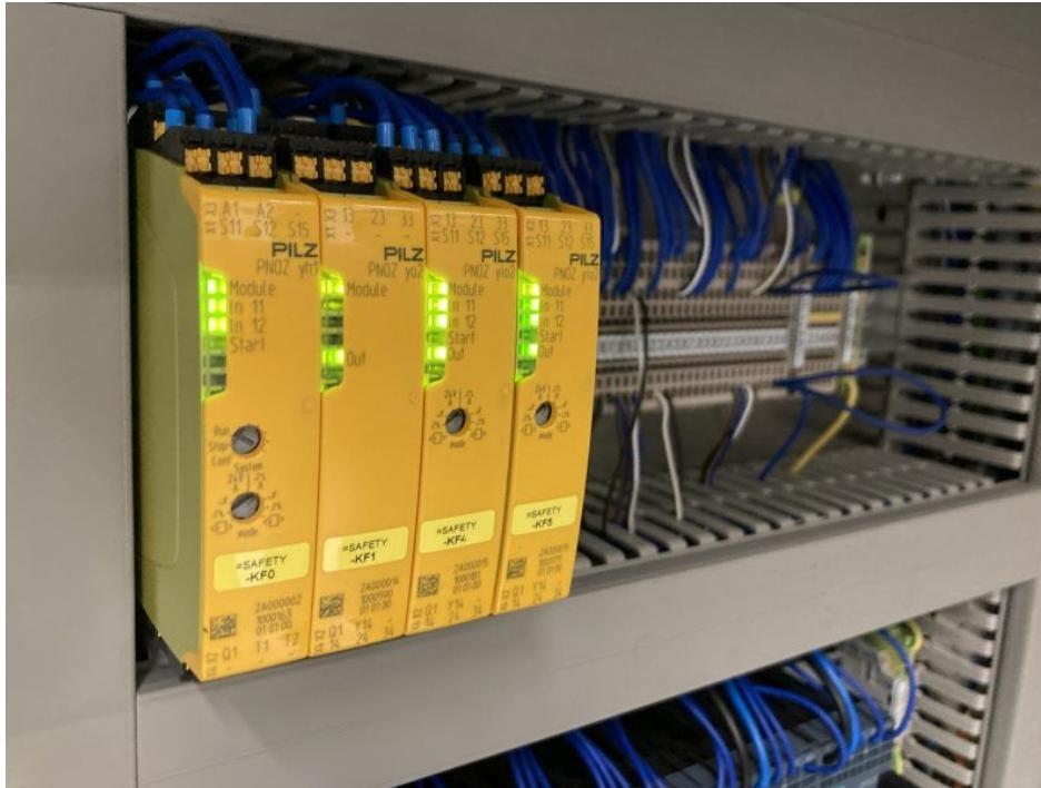
Blick in den Schaltschrank einer aktuellen Maschine: Der kompakte »myPNOZ«-Modulblock wird von Pilz einsatzbereit geliefert: vormontiert, eingestellt und getestet (Bild: Pilz).
