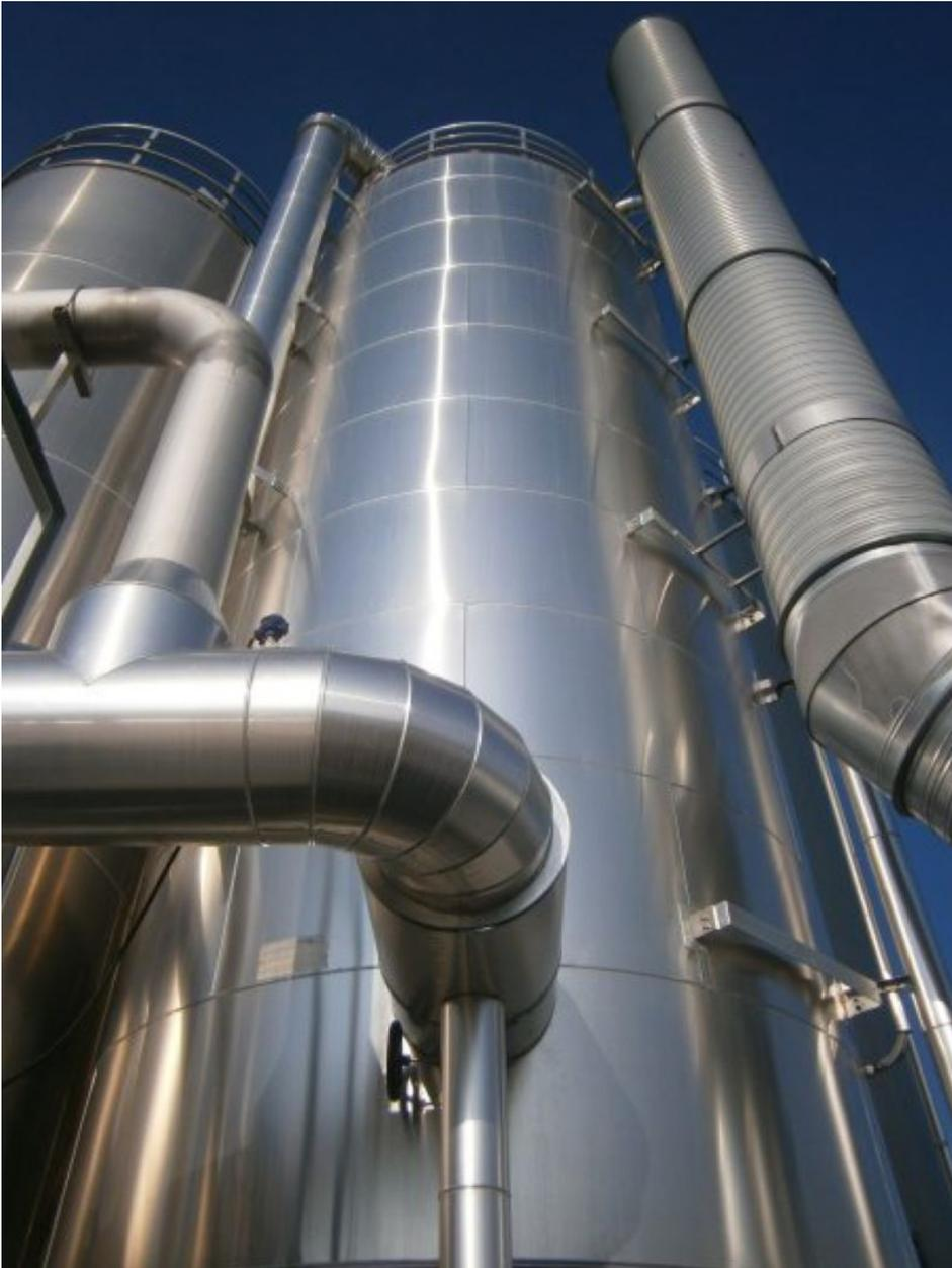
Die Desodorierungssysteme für den kontinuierlichen und diskontinuierlichen Betrieb entfernen in einem thermischen Prozess flüchtige organische Verbindungen aus den rezyklierten Kunststoffen (Bild: Zeppelin Systems).
