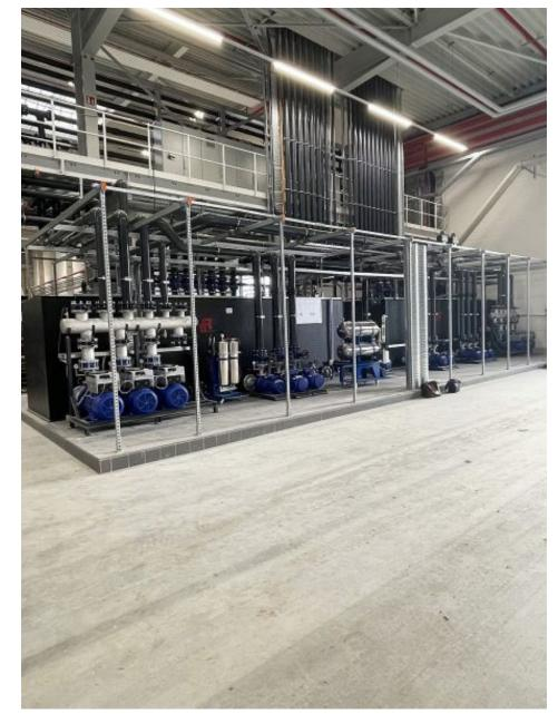
Im neuen Werk von Craemer stellen drei Kältemaschinen mit einer Kälteleistung von jeweils 500 Kilowatt 12 Grad Celsius kaltes Kühlwasser für die Werkzeugkühlung bereit (Bild: L&R).
