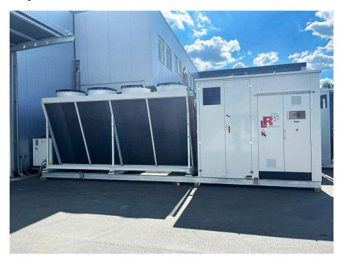
Die adiabatischen PAD-Kühler für die Temperierung des Hydraulikkreislaufs gewährleisten bei Außentemperaturen bis 35 Grad Celsius eine Kühlung aus der Umgebung ohne externe Energiezufuhr (Bild: L&R).
