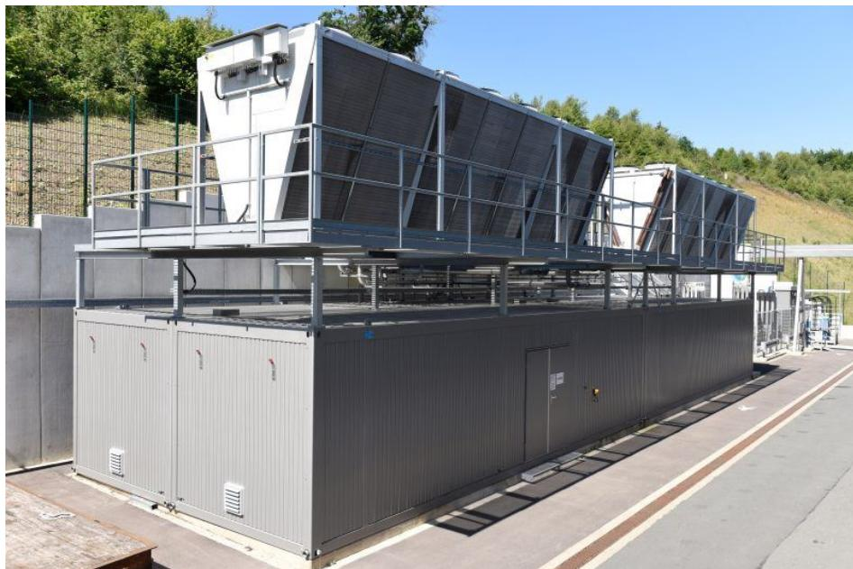
Das Kühlsystem besteht aus einer Containerlösung, die eine Kühlleistung von zwei Megawatt erzeugt (Bild: [technotrans](#)).
