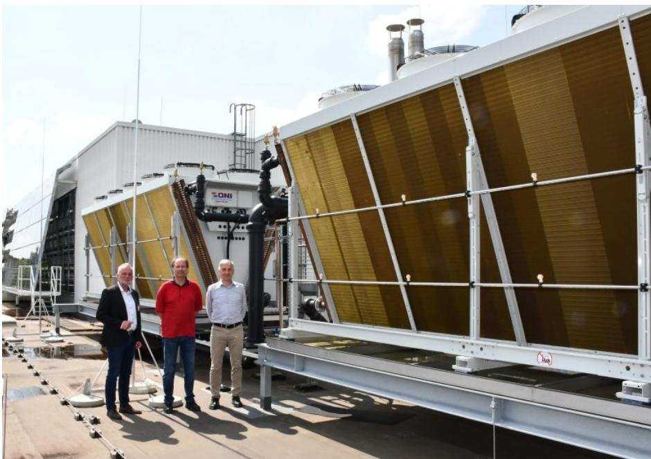
Die Rückkühlwanlage für die wassergekühlten Kältemaschinen ist beeindruckend. Die dafür eingesetzten V-Kühler mit je einer Leistung von 400 Kilowatt wurden auf dem Kantinendach aufgestellt. V. r.: Peter Eberhardt und Frank Pabst (fischerwerke) zusammen mit Udo Greifenberg (ONI-Gebietsverkaufsleiter) bei der Anlagenabnahme (Bild: ONI).
