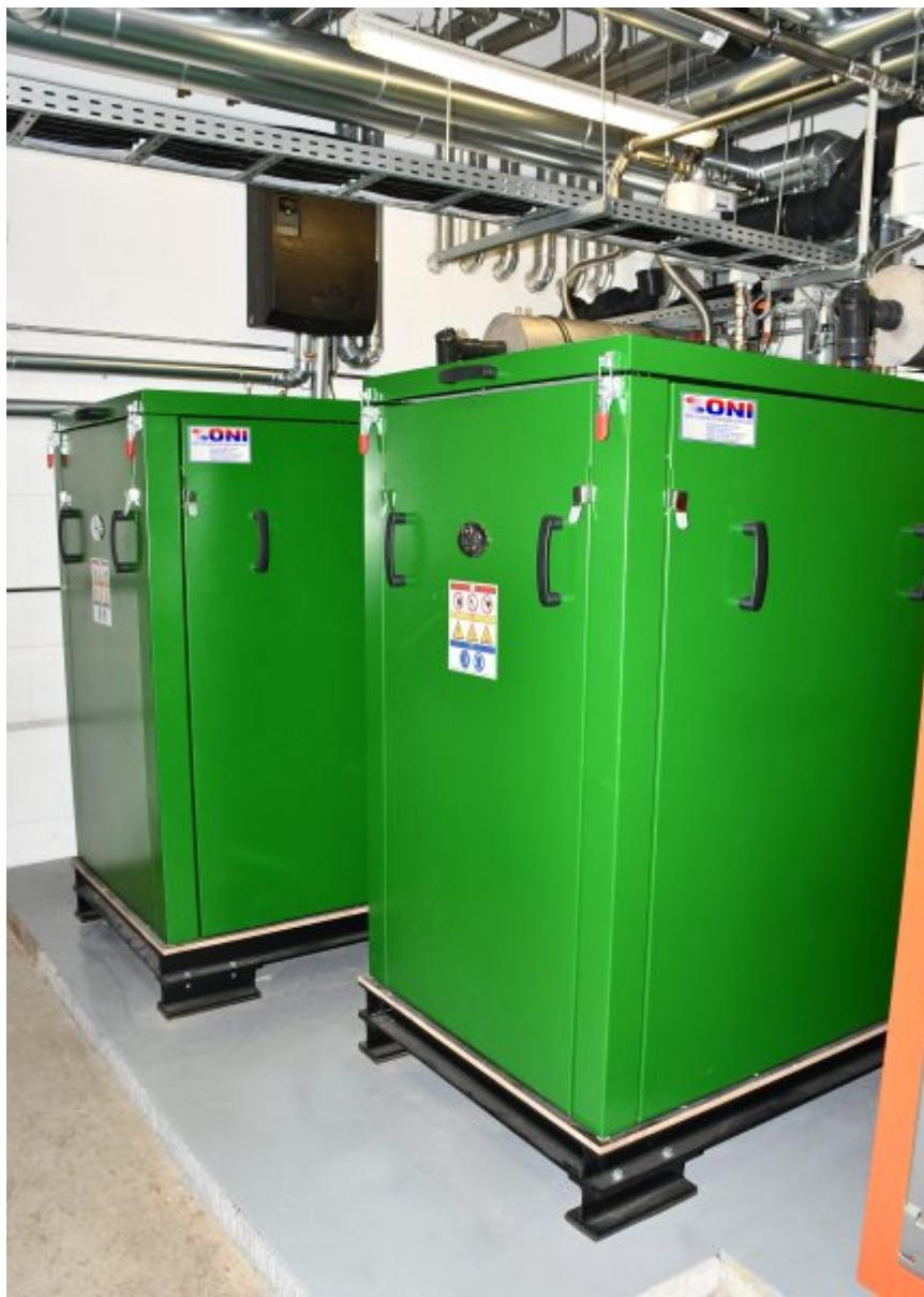
Die BHKW-Anlage sorgt für die Deckung eines elektrischen Grundlastbedarfes von 100 Kilowatt und liefert gleichzeitig 180 Kilowatt Abwärme, die für die Erzeugung von Kühlenergie über eine Absorptionskältemaschine genutzt wird (Bild: ONI).
