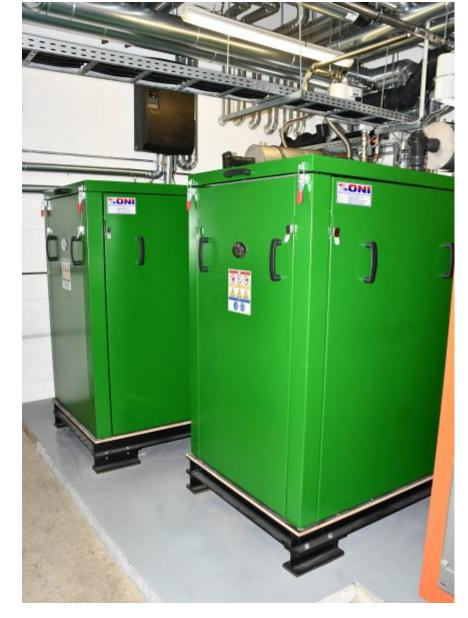
Die BHKW-Anlage sorgt für die Deckung eines elektrischen Grundlastbedarfes von 100 Kilowatt und liefert gleichzeitig 180 Kilowatt Abwärme, die für die Erzeugung von Kühlenergie über eine Absorptionskältemaschine genutzt wird (Bild: ONI).
