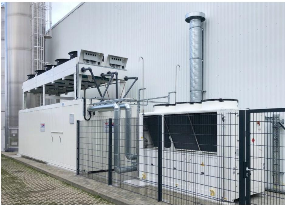
Zweikreis-Containerkühlanlage mit einer glykolfreien, automatisch leerlaufenden Freikühlerdoppeleinheit. Im Sommerbetrieb liefert sie die Kühlenergie für die Maschinen und in der Übergangs-/Winterzeit übernimmt sie die Arbeit der Kältemaschine (Bild: ONI).
