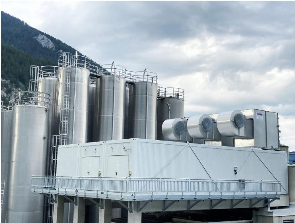
Die komplette Einheit bringt mehr als 300 Tonnen Betriebsgewicht auf die Waage. Zur Aufstellung der drei Rückkühlwerke wurde platzsparend das Dach der Container genutzt (Bild: ONI).
