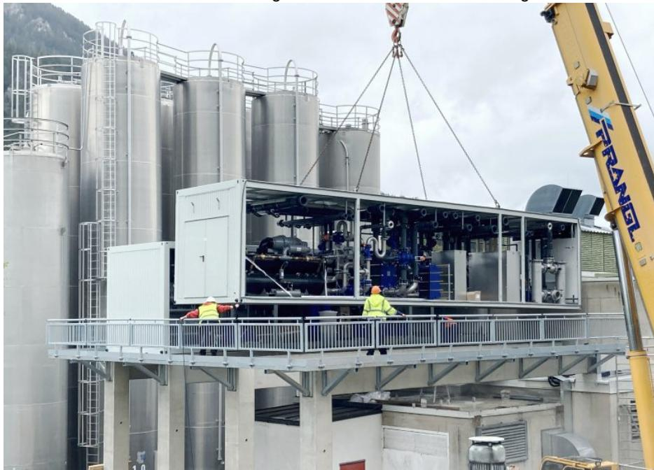
Auf mit Pfeilern abgestützten Fundamenten wurden in luftiger Höhe die drei Module der ONI-Container-Kühlanlage zu einer Einheit zusammengesetzt. Hier wird das 2. Modul der Anlage millimetergenau eingepasst (Bild: ONI).
