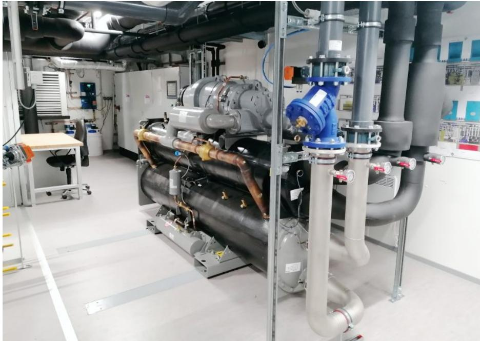
Hocheffiziente Kältemaschinentechnik mit dem Kältemittel R515B bildet die Grundlage für ein zukunftssicheres Kältekonzept (Bild: ONI).
