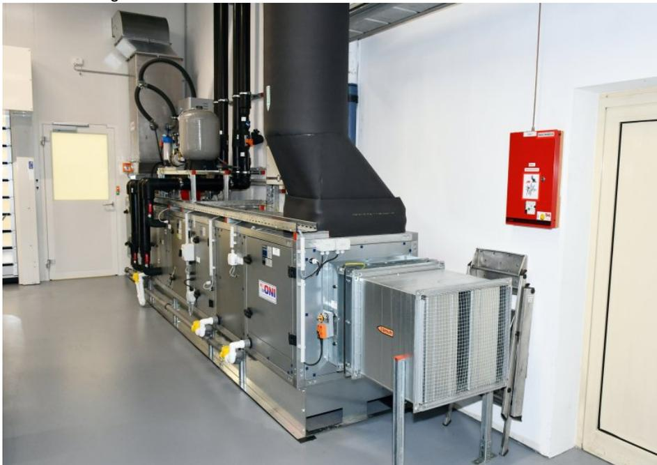
Das Klimagerät ist mit einem Kühlregister zur Kühlung und Entfeuchtung, einem Heizregister zur Nutzung von Abwärme, Filtereinheiten zur Reduzierung der Partikelanzahl sowie einer Befeuchtungseinheit für den Winterbetrieb ausgerüstet (Bild: ONI).
