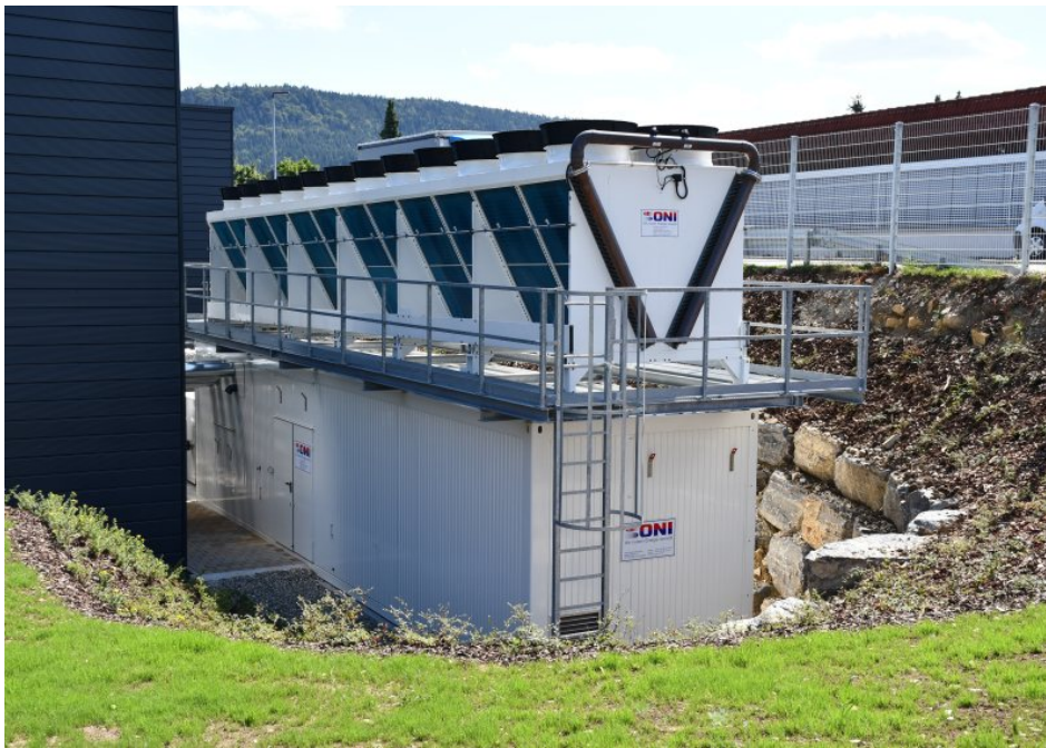
Container-Kühlanlage mit aufgesetztem V-Freikühler (Bild: ONI).
