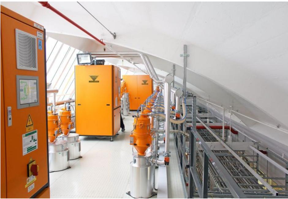
Alle Behälter der Trocknungsanlage wurden in den Boden der Bühne eingelassen. Bild: Koch-Technik
