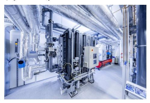
2 LR WinkelmannAbsorptionska.jpg Die Absorptionskältemaschine wird im Sommer vom hauseigenen BHKW mit Wärme versorgt. Bild: L&R
