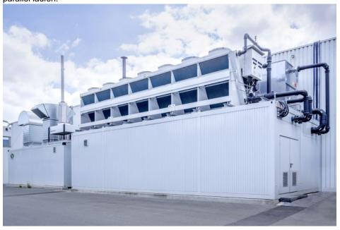
Platzsparende Lösung: Der Freikühler wurde auf dem Container installiert. Bild: L&R
