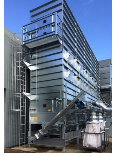
Die Absaug- und Filteranlage Typ »Validus« von Schuko lässt sich als Bestandteil energiesparender Absaugsysteme in vielen Branchen nutzen.
