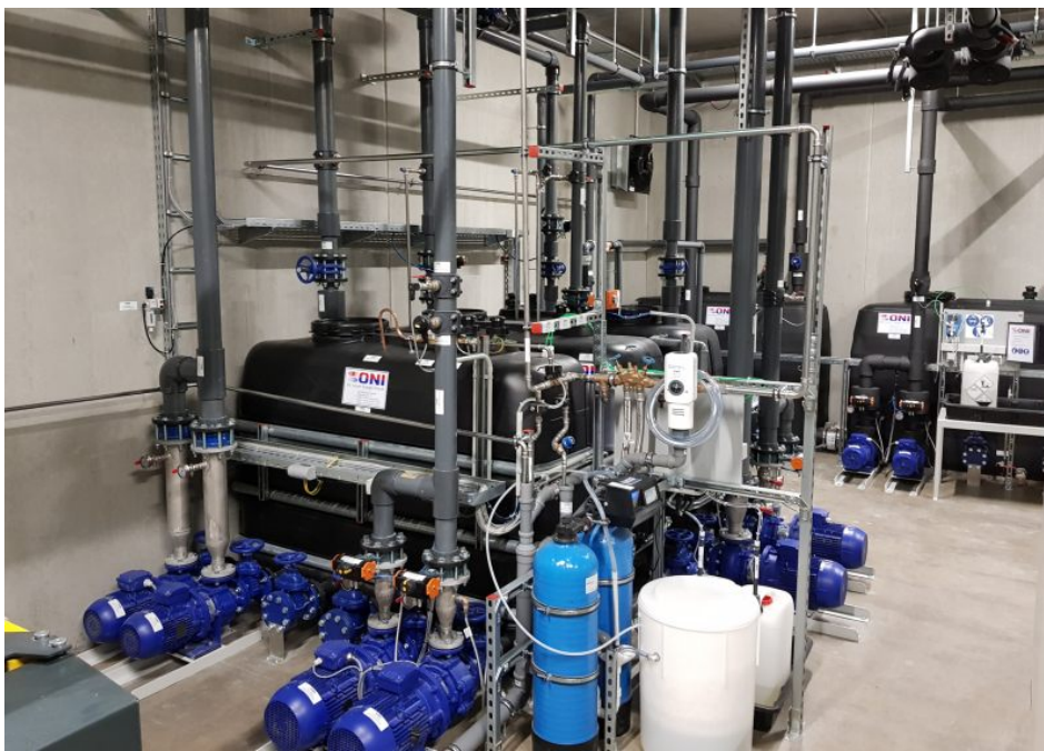
Voraussetzung für die Mehrfachnutzung eingesetzter Energie in den Maschinenkühlkreisen sind geschlossene, glykolfreie Kühlkreisläufe. Bild: ONI
