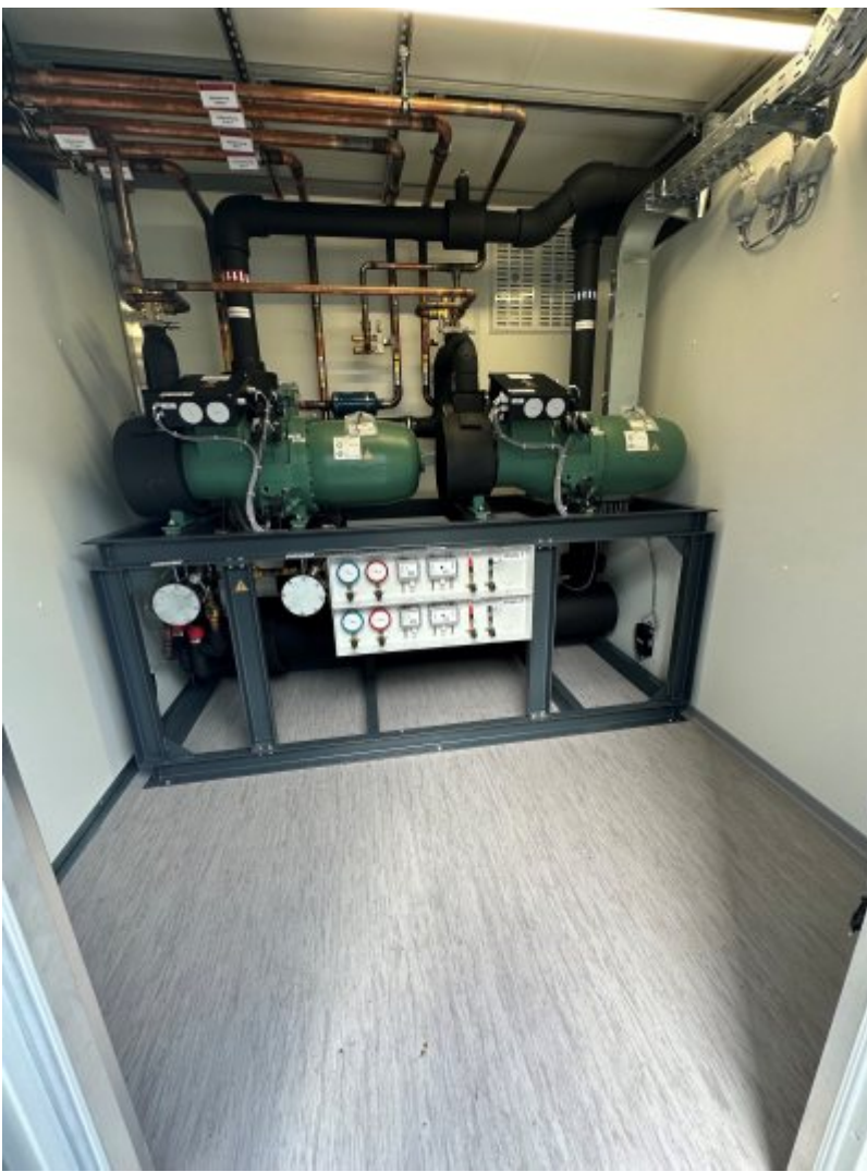
Kälteanlage mit natürlichem Kältemittel (R 290) im Container verbaut (Bild: L&R).
