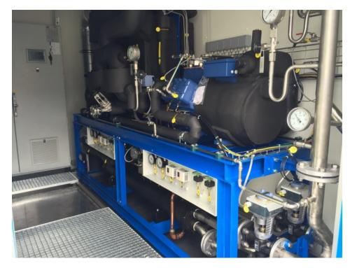
Beispiel für eine Propan-Kältemaschine (Bild: L&R).
