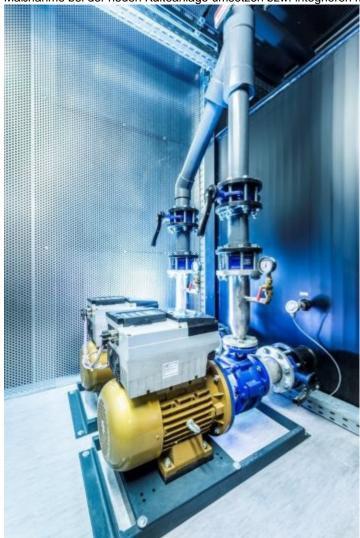
Drehzahlgeregelte Pumpen (Bild: L&R).
