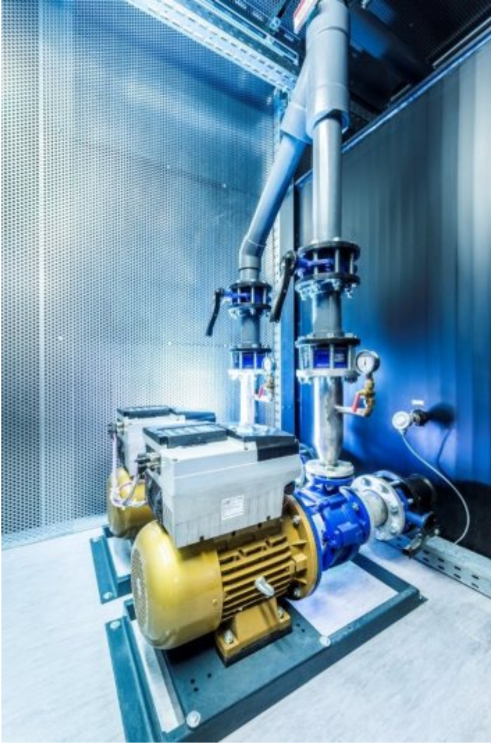
Drehzahlgeregelte Pumpen (Bild: L&R).
