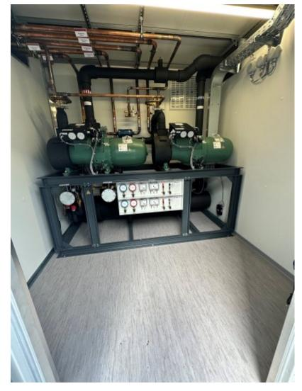
Kälteanlage mit natürlichem Kältemittel (R 290) im Container verbaut (Bild: L&R).
