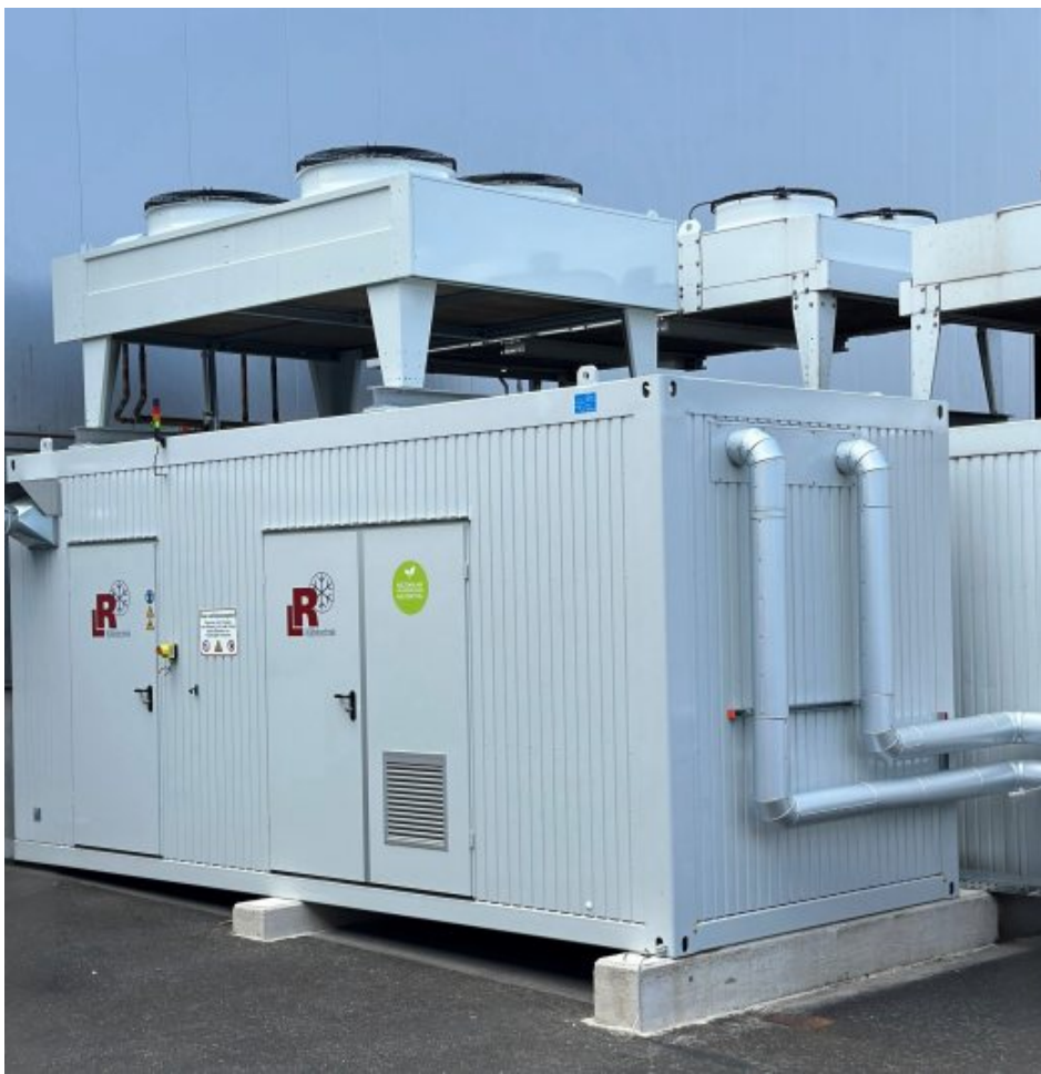
Beispiel für einen Freikühler (Bild: L&R).
