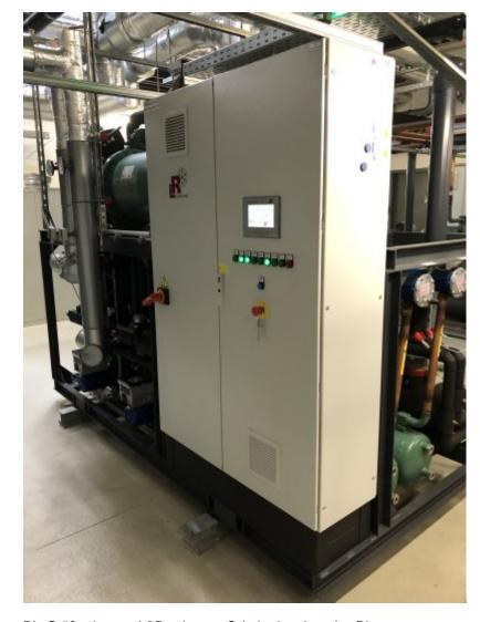
Die Größe des von L&R gebauten Schaltschranks zeigt: Die energieeffiziente Kopplung von Kälte- und Wärmeerzeugung erfordert hohen Steuerungsaufwand (Bild: L&R).
