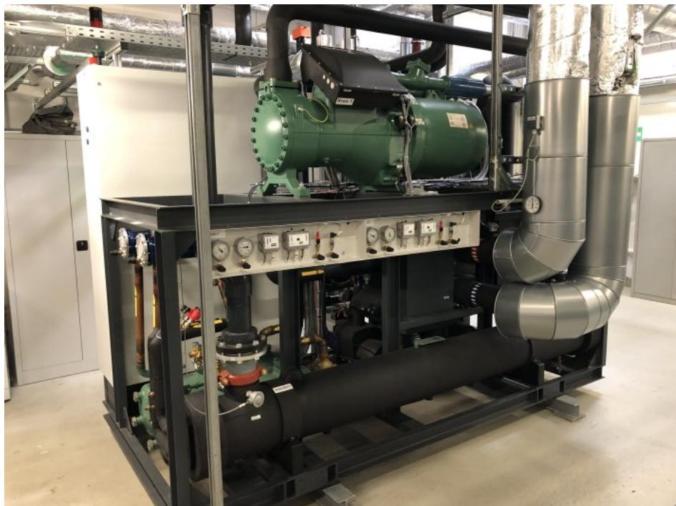
Die projektierte Industrie-Wärmepumpe erzeugt Kälte für die Kunststoffverarbeitung und liefert zugleich Wärme für die Heizung und Warmwasserbereitung im Betrieb (Bild: L&R).
