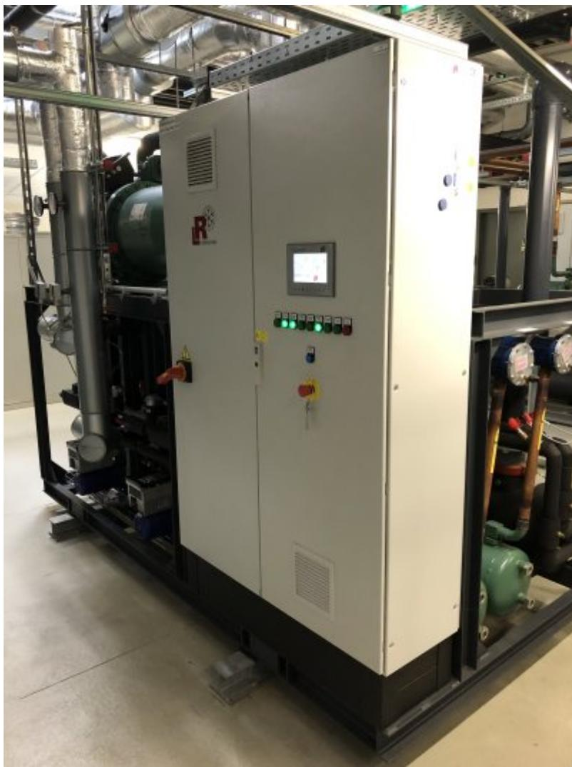
Die Größe des von L&R gebauten Schaltschranks zeigt: Die energieeffiziente Kopplung von Kälte- und Wärmeerzeugung erfordert hohen Steuerungsaufwand (Bild: L&R).
