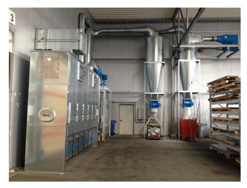
Filter- und Absaugtechnik mit Materialvorabscheidung trägt zur hohen Produktqualität in der Kunststoffindustrie bei (Bild: Nestro).
