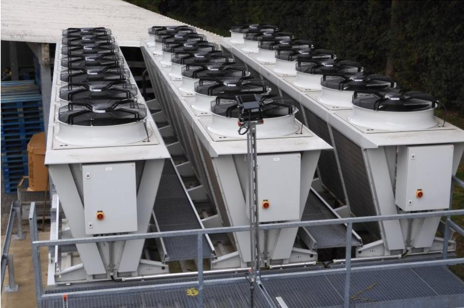
Kompakt und komplett: Die Kondensatoren für die Abführung der Wärme von den Kälteanlagen finden auf dem Dach des Containers Platz (Bild: L&R).
