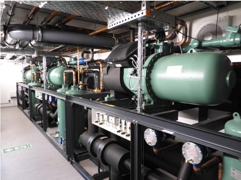
Herzstück dieser Container-Kälteanlage sind drei hocheffiziente Kältemaschinen in Split-Bauweise und je 450 kW Leistung (Bild: L&R).
