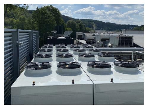
Beispiel Winterentlastung – Teil der Kühlanlage mit einer Kälteleistung von 1,35 MW für einen nordrhein-westfälischen Hersteller von Kunststoffverpackungen (Bild: L&R).
