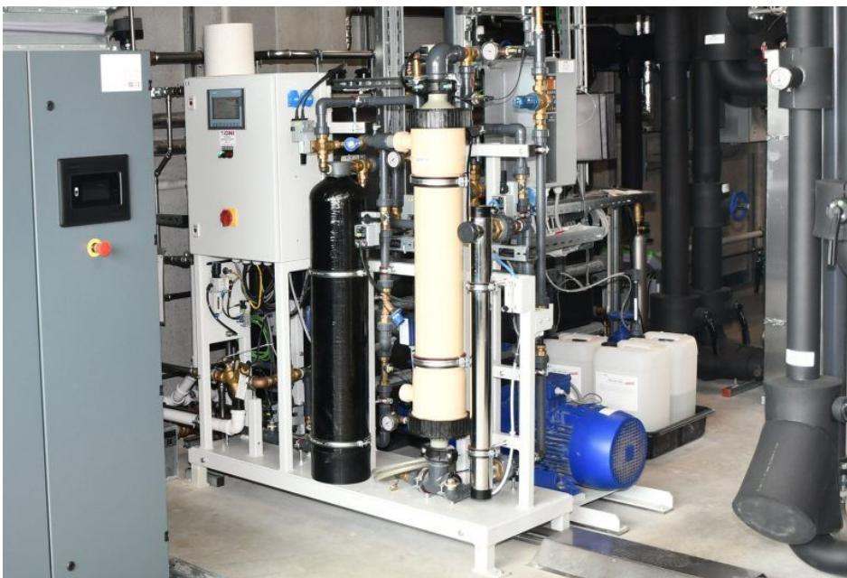
Das ONI-»AquaClean«-System sorgt für eine hervorragende Wasserqualität in den Kühlkreisläufen für die Maschinen und Werkzeuge durch eine mehrstufige Filtration und Ozonisierung ohne Einsatz von Chemie (Bild: ONI).
