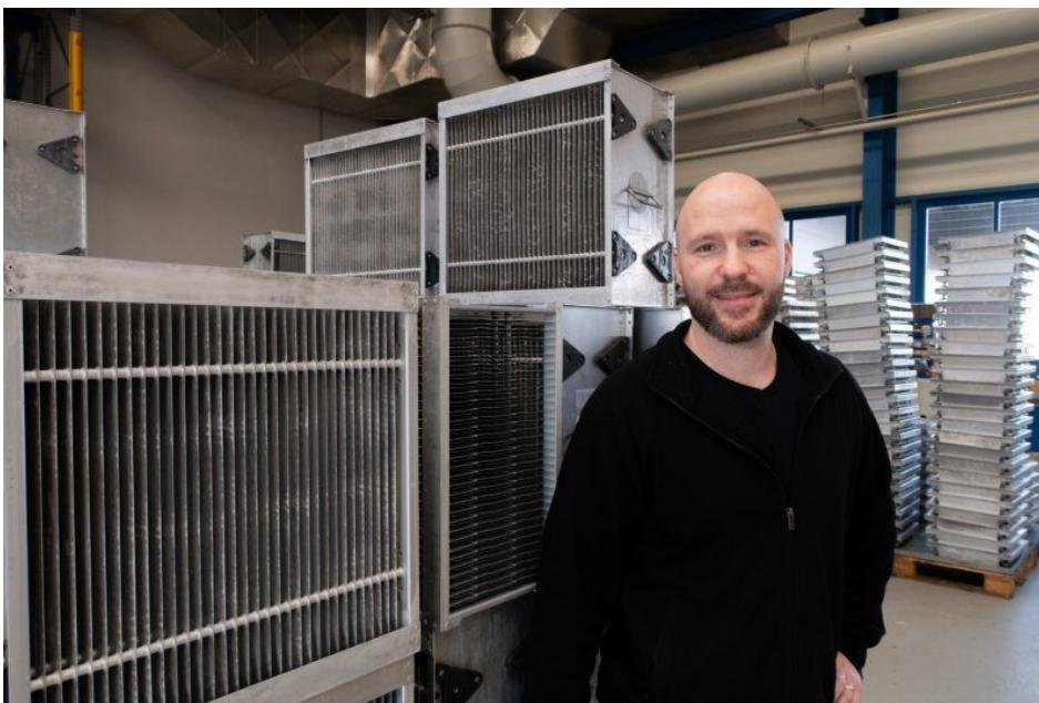
Wartung und Reinigung der Filter ist zentraler Bestandteil der Serviceleistungen von Büchel. Autor Thomas Frey zeigt die gereinigten und eingelagerten elektrostatischen Filter, die schnell beim Kunden getauscht werden können (Bild: Büchel).
