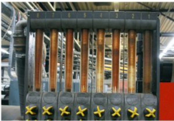
Vor der Inbetriebnahme der »AquaClean«-Anlage: Wasserbatterie mit verschmutzten Gläsern.
