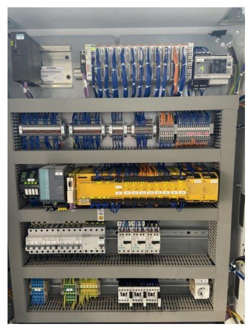
Übersichtlich und spart Platz: »PNOZmulti« mit »PSENradar«-Modulen, die Auswerteeinheit oben rechts, im Schaltschrank (Bild: Weidplas).
