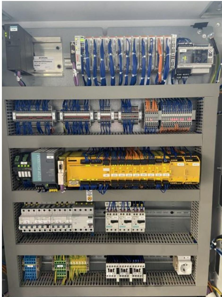
Übersichtlich und spart Platz: »PNOZmulti« mit »PSENradar«-Modulen, die Auswerteeinheit oben rechts, im Schaltschrank (Bild: Weidplas).
