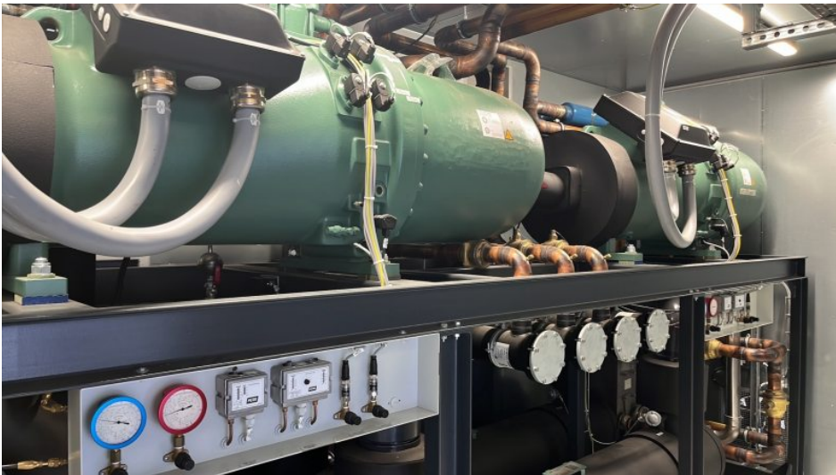
Kältemaschine im Container- Als Kältemittel wird Propan/R290 verwendet (Bild: L&R).
